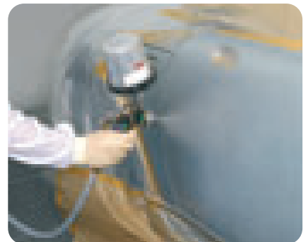
Komplette Teile mit Klarlack lackieren. Achten Sie dabei darauf, im Randbereich zum Nachbarteil den Klarlack möglichst dünn aufzutragen.
